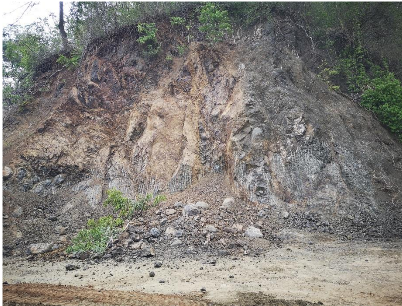
Figura 4. Corte de talud en rocas de la Formación Santa Teresa en contacto con el Complejo de Nicoya en la zona de falla del Pull Apart sitio 1104895 N- 319231 E
